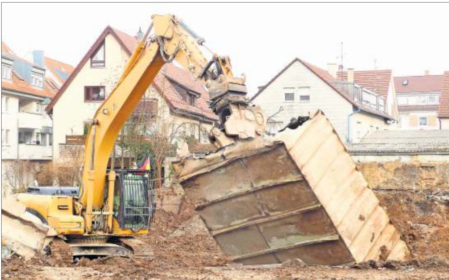
Rund um das Wüst-Areal will das Stadtmarketing die Einzelhändler mit Baustellenmanagement unterstützen.
