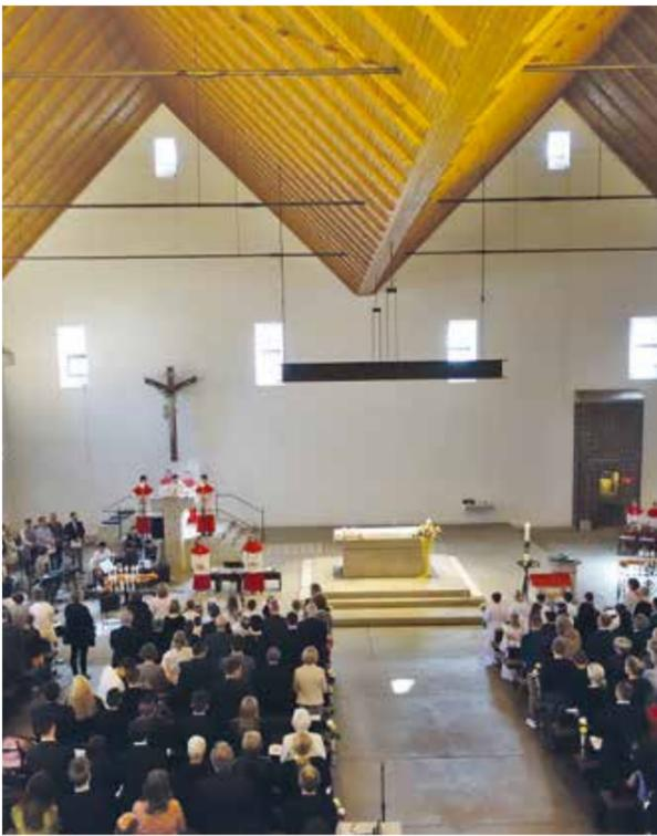
Der Altarraum ist groß und weit, das Kirchenschiff kommt ohne Pfeiler und Säulen aus. Statisch ist das eine Herausforderung. Das Dach ist freitragend, die Empore an selbigem aufgehängt. Sie hat in dem schweren, offenen "Baldachin" aus T-Trägern über dem Altar ihr Gegengewicht.
